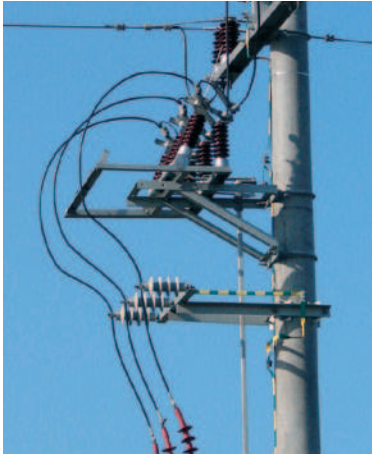
zabezpieczenie kabla SN – zejście z linii napowietrznej
