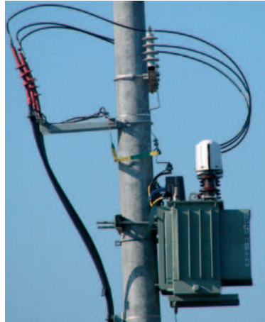
zabezpieczenie uproszczonej stacji transformatorowej 15/0,4 kV
