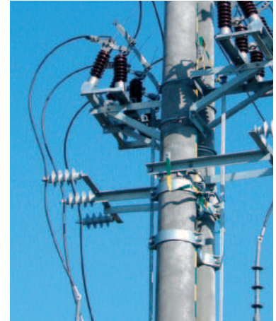
zabezpieczenie kabla SN – zejście z linii napowietrznej
